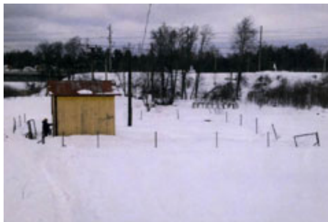
Рис. 1. Очистные сооружения железнодорожной станции Белоостров.
